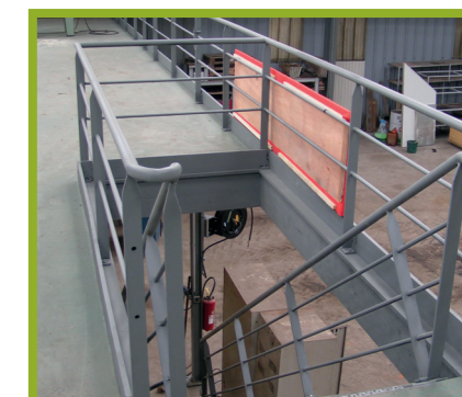
Escalier et garde corps
